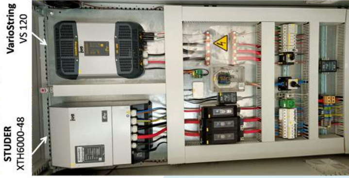
Cabinet central de production d'énergie
